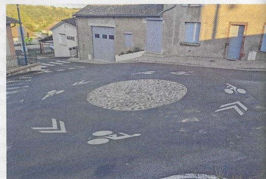
Exemple de mini-giratoire avec logos vélo et chevrons.
